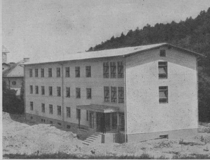
Samski dom Mestne kanalizacije v Ljubljani
