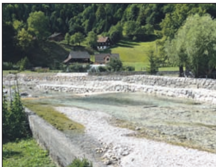
Dela pri ureditvi protipoplavnih ukrepov struge reke Savinje in pritoka Lučnice, predvidena v prvi fazi, so praktično končana.
