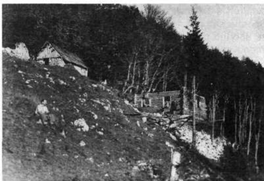
Zgoraj prvi pastirski stan na Kališču, spodaj gradnja Jalnove kočice na Kališču
