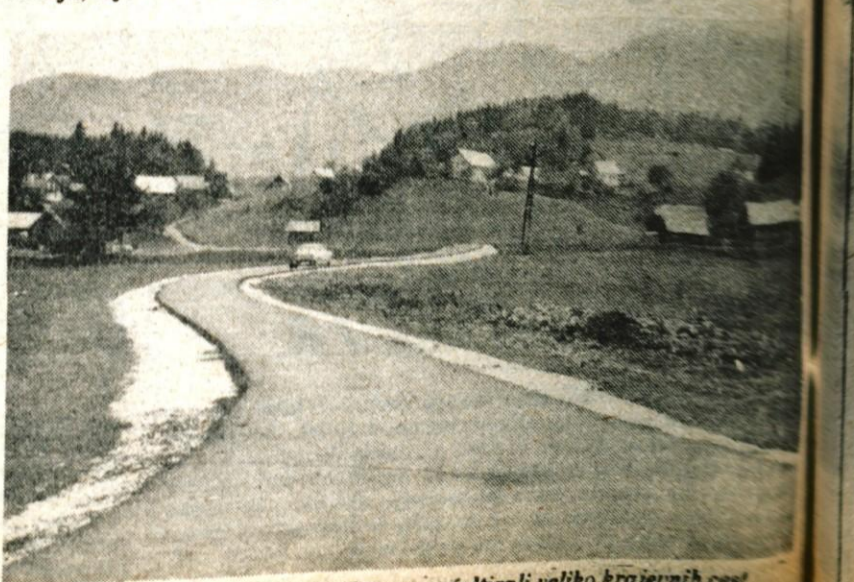
Na Gorjušah in na Koprivniku so asfaltirali veliko krajevnih cest
