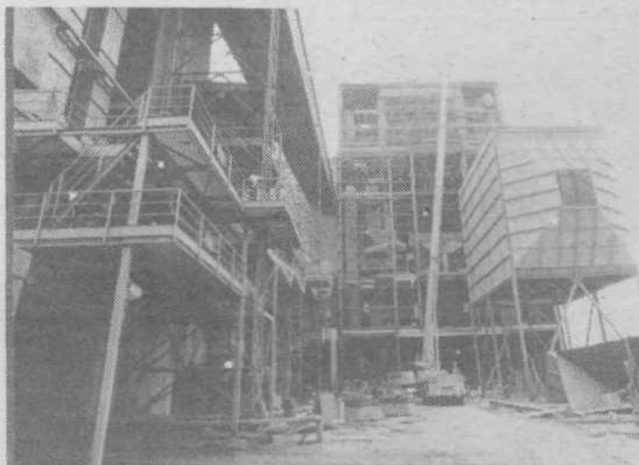
Gradnja 2. faze toplotarne je v polnem teku. Če bo šlo vse po načrtih, naj bi proti koncu letošnjega leta že stekla poskusna proizvodnja. Na sliki: parni kotel z zmogljivostjo 270 ton na uro, pare parametrov 115 barov in temperature 535°C.
