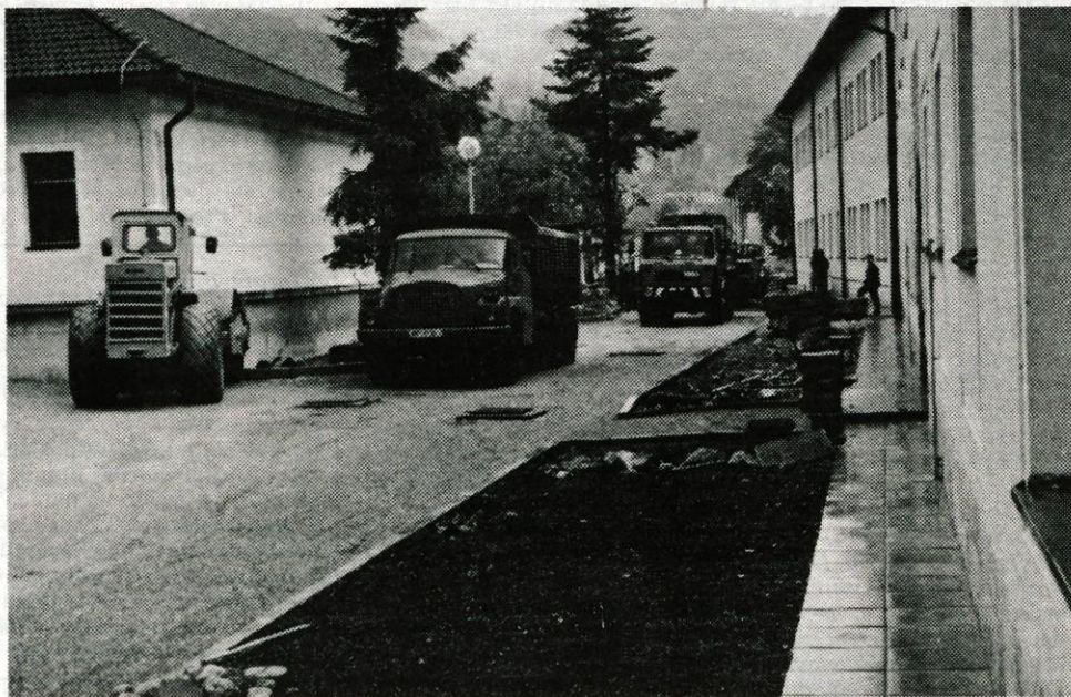
NOVA PODOBA VOJAŠNICE NA BOHINJSKI BELI - Prve vojake pričakujejo v tej vojašnici sicer šele začetek oktobra, vendar mora biti prenova stavb končana že dva meseca prej. Od konca marca naprej so rekonstruirali 8 starih objektov in postavili enega novega. V prostorih že vsa oprema. Ko bodo uredili še okolico, bo pogled na vojašnico mnogo lepši kot v preteklosti. (Več na Odprtih straneh) S. Saje - Foto: P. Kozjek
