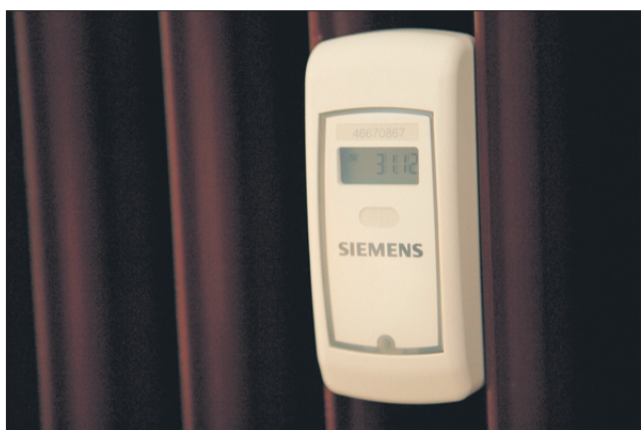
Vgradnja delilnikov je tudi zakonsko predpisana. Obvezni bodo prihodnje kurilno sezono, s 1. oktobrom 2011. V Celju so delilniki vgrajeni že v približno 80 odstotkih večstanovanjskih stavb. (Foto: GrupA)
