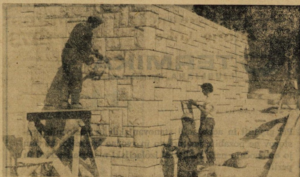
Hotaveljski kamnoseki pri montaži
