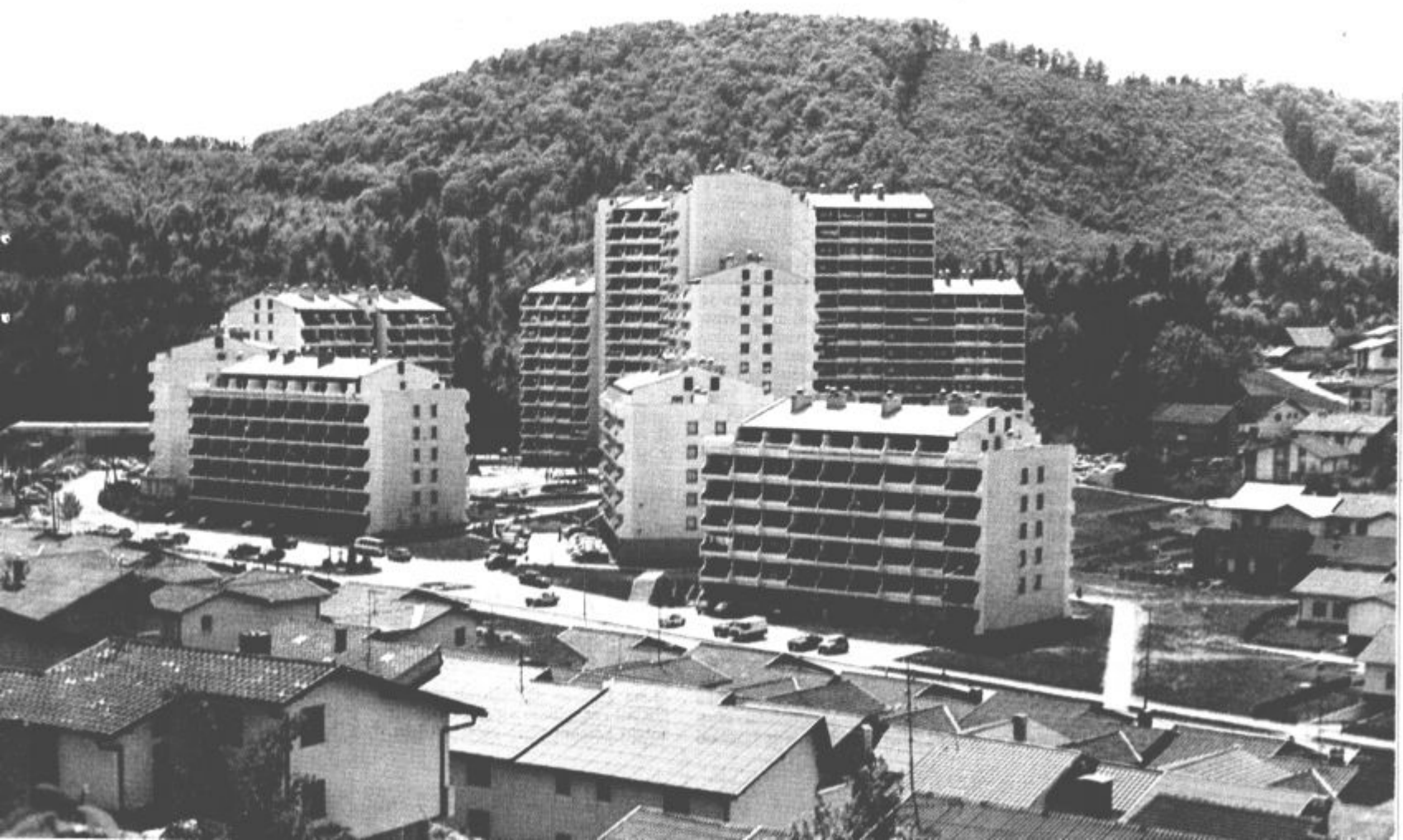
Nova stanovanjska soseska Šalek—Gorica
