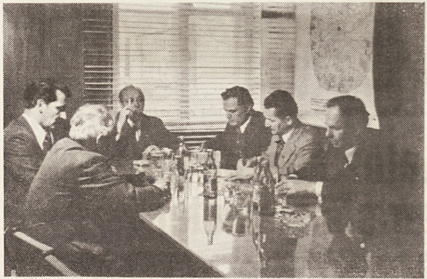
Razgovor na gradbišču
