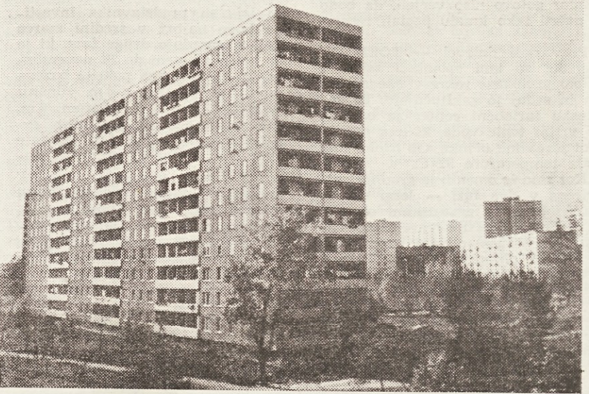
Nov stanovanjski blok
