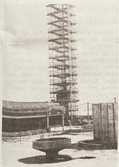
Ob objektu z garderobo gradimo 19 m visok dimnik
