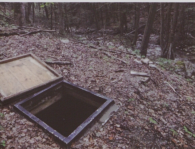
Vhod in notranjost bunkerja pri nekdanji Hlipovčnikovi žagi. Bunker obnovljen leta 2013. Foto Janez Turk.
