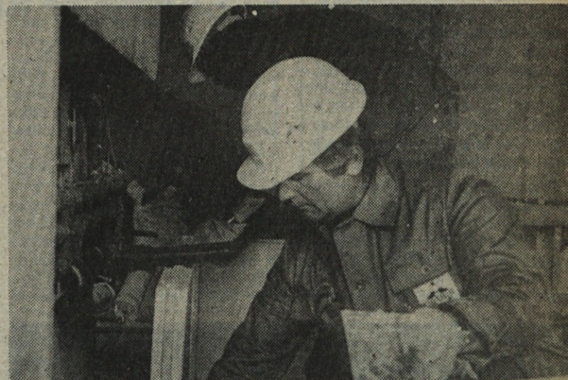
Zidarja Marko Habić in Safet Hrvanović sta uspešno opravila svojo nalogo, saj so zidali v noem bloku soseske na Planini
