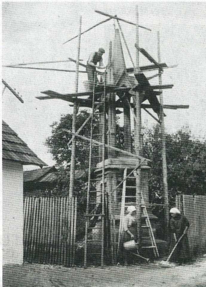
Mojster Franc Zobavnik pri zaključnih delih gradnje kapelice pri Končkovih v Šmarci leta 1919.
