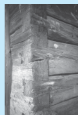
□ Slika 7. Razvoj vogalnega stika lesenih sten v avtohtoni arhitekturi; slike do črte kažejo razvoj do 17. stoletja, slika za črto tehnično izvedbo detajla od takrat do danes (čeprav so se starejše oblike pojavljale tudi kasneje-opazujemo najnaprednejše oblike) (Frick, 1997: 98; Cevc, 1984: 62,65; Deu) Development of corner connections of massive wooden walls in identity architecture, the pictures to the line show development till 17 th century, 4 th picture shows technical realization of detail since 17 th century till now (Frick, 1997: 98; Cevc, 1984: 62,65; Deu)
