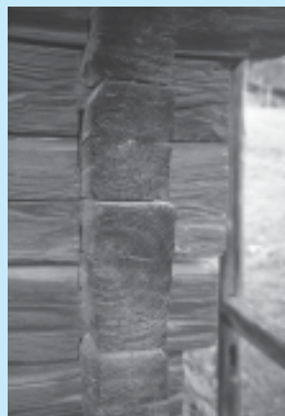
□ Slika 7. Razvoj vogalnega stika lesenih sten v avtohtoni arhitekturi; slike do črte kažejo razvoj do 17. stoletja, slika za črto tehnično izvedbo detajla od takrat do danes (čeprav so se starejše oblike pojavljale tudi kasneje-opazujemo najnaprednejše oblike) (Frick, 1997: 98; Cevc, 1984: 62,65; Deu) Development of corner connections of massive wooden walls in identity architecture, the pictures to the line show development till 17 th century, 4 th picture shows technical realization of detail since 17 th century till now (Frick, 1997: 98; Cevc, 1984: 62,65; Deu)
