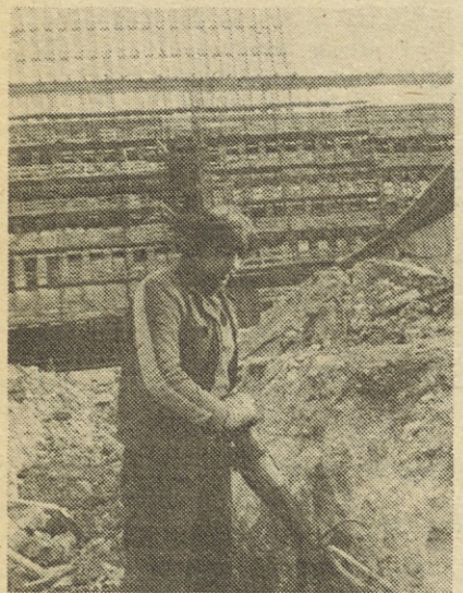
Gradnja prizidka Iskrinega PPC teče po načrtu.
