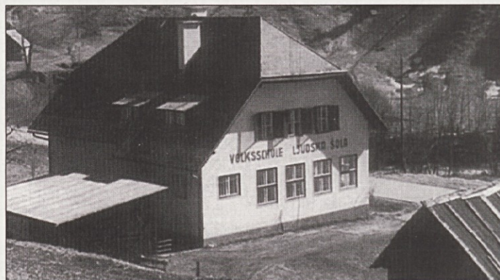
Ljudska šola na Obirskem je nujno potrebna sanacije.
