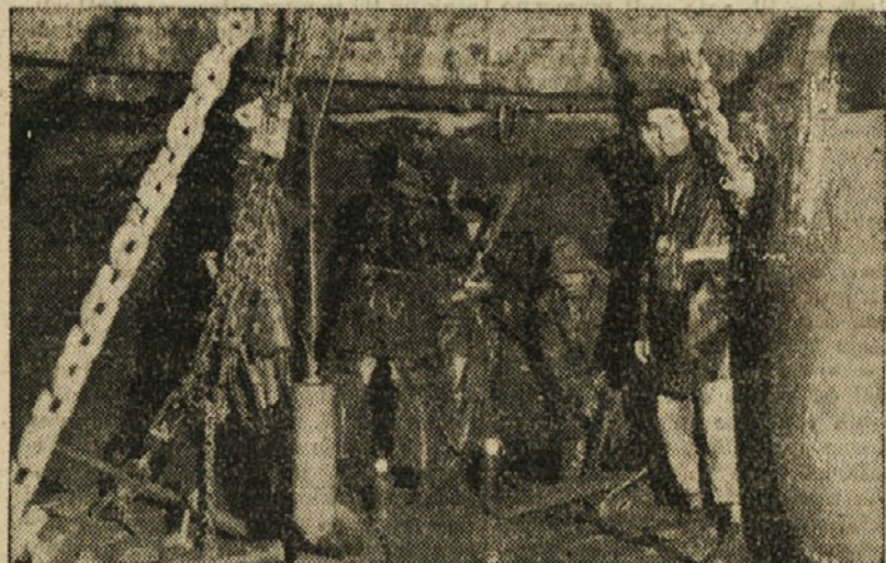
Delo na visečem odru pri betoniranju jaška
