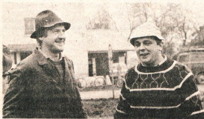
»Gonilna sila« gradnje gasilskega doma sta bila Franjo Modrijan in vodja gradbenega odbora Ciril Kos: »Ne smemo popustiti, dokler ne bo dom povsem končan. Vabimo pa vse krajanje, da nam vsaj enkrat priskočijo na pomoč.«
