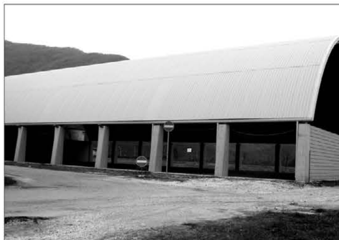
Il campo di calcetto in fase di realizzazione a S. Pietro al Natissone
