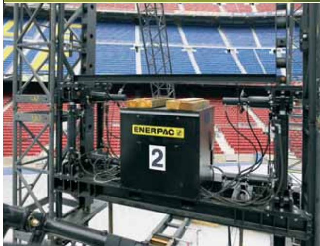
Postavljanje noge odra (zgoraj) in hidravlični pogonski sistem dvižnih in varovalnih valjev (spodaj)
