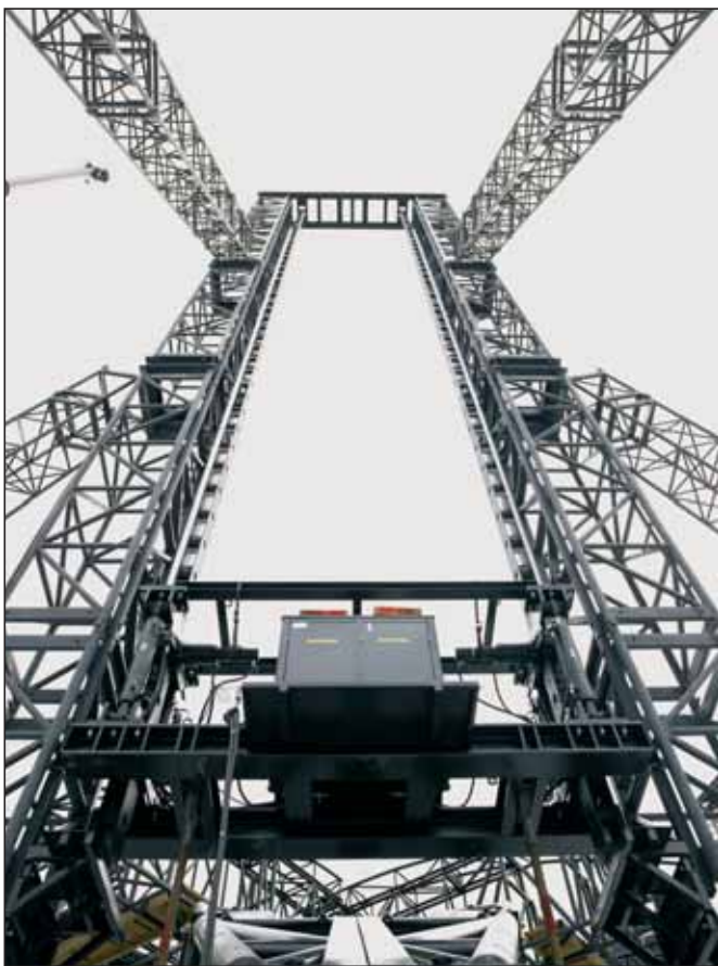
Za vsako nogo odra je postavljen začasni portal (dvižni stolp) s prečnim nosilcem
