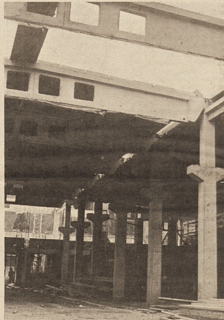
Gradnja velike nove strojne delavnice, ki bo predvidoma zaključena že konec meseca septembra letos
