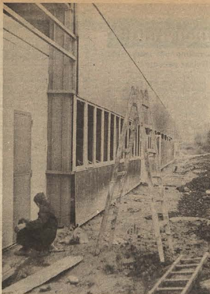
V Rosalnicah pri Metliki lepo napreduje gradnja nove proizvodne dvorane za podjetje KOMET. Gradnja montažnega tipa se bliža koncu. Ko bo podjetje doslej razstreseno proizvodnjo na več koncih Metlike preneslo v novi objekt, se bo začelo za kolektivno novo obdobje. (Foto: R. Bačer)
