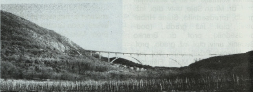
Slika 1: Študija vključitve viadukta v prostor - računalniška fotomontaža, pogled na variantne rešitve viadukta iz Osapske doline, (od zgoraj navzdol: PP140, PP105, PP180 in PL230)
