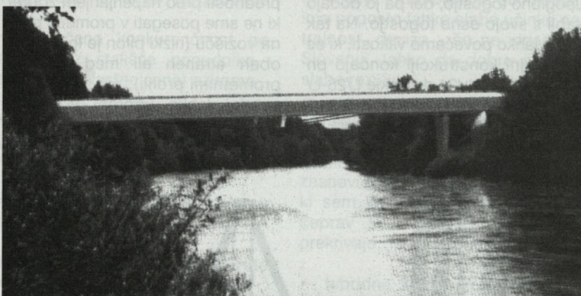
Slika 4: Natečajna rešitev Brod3 za most čez Muro z napenjanjem po spodnji strani
