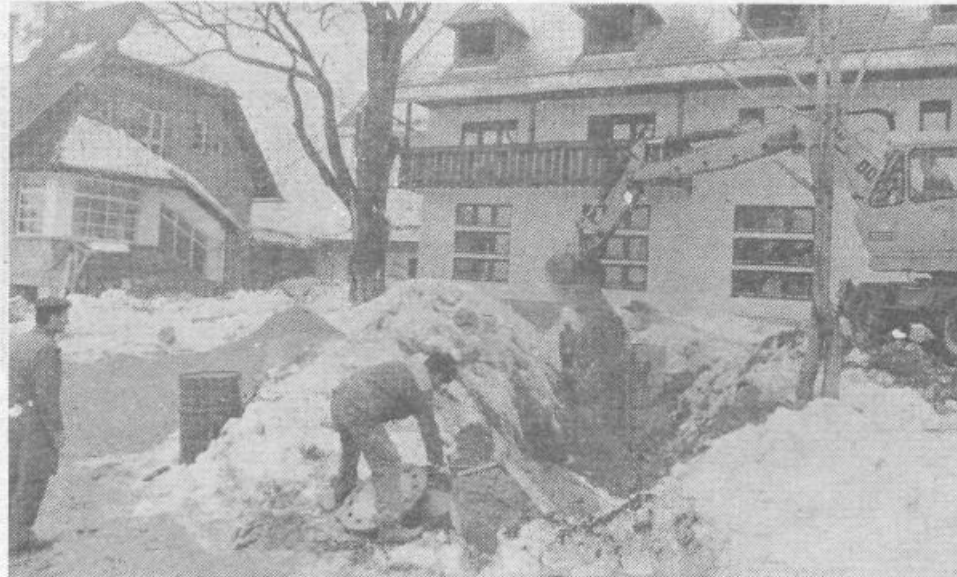
Gradnja na Rakitni se bliža koncu
