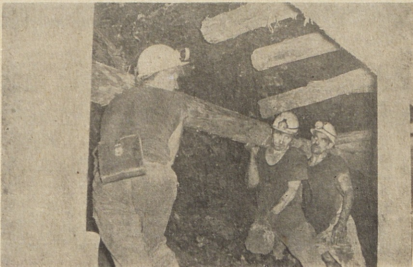
Vgrajevanje lesenega stropnika na širokem čelu
