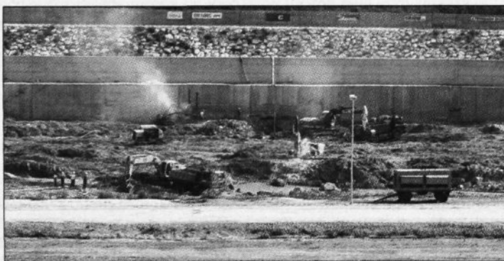
Na gradbišču HE Boštanj je vsak dan bolj živahno.
