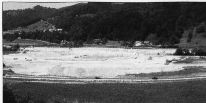
Pogled na gradbeno jamo, ki nastaja ob Spodnji Savi.
