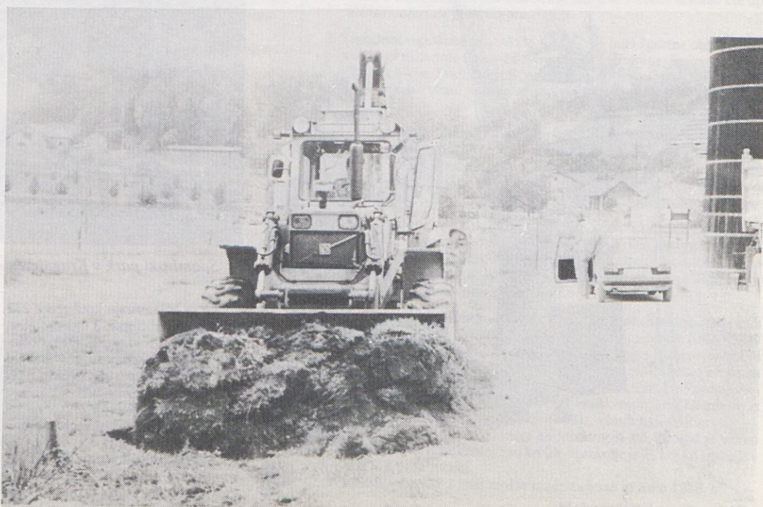
Del cestne povezave proti Temenici bo kot vse kaže dobil asfaltno prevleko. Na pomoč je priskočila enota JLA.
