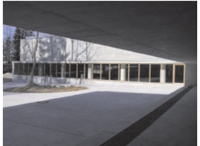
Slika 10: Vhodni nadstrešek. Entrance canopy.
