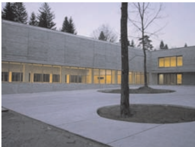
Slika 5: Vhod, telovadnica, knjižnica v nadstropju. Entrance, gym, library on first floor.
