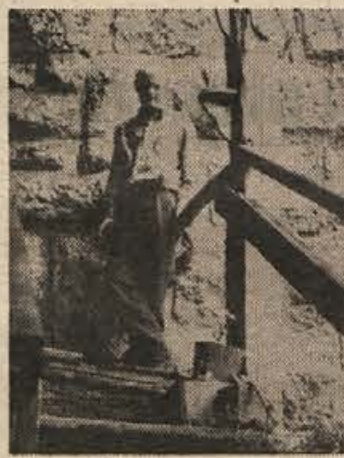
Franc Čečelič na dotrajanih stopnicah: „Bojim se, da se mi bodo nekega dne zrušile na glavo.“ (Foto: J. P.)
