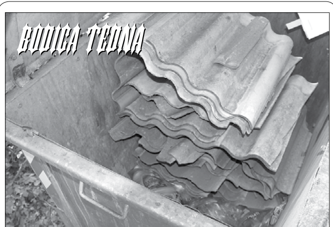
Azbestni odpadki sodijo le na posebno odlagališče nevarnih gradbenih odpadkov. (Foto: Jože Miklavc)
