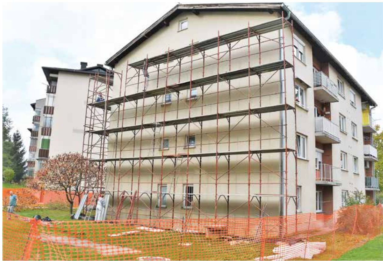
Začetek del na fasadi bloka Na zelenici 12
