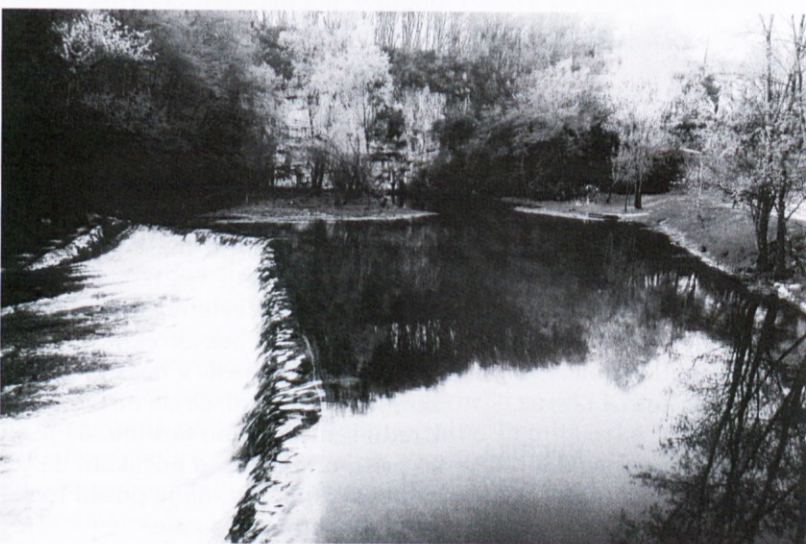
Obnovljeni jez pri izviru Krupe (2006).
