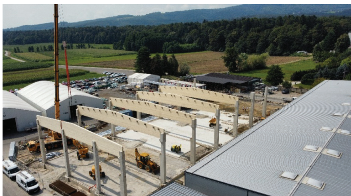
Sliki 11 in 12. Leseni lepljeni nosilci, povezani s sekundarnimi lesenimi nosilci.
