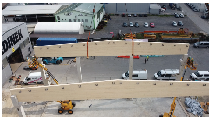
Slika 10. Montaža krajnega lesenega nosilca na armiranobetonske stebre.
