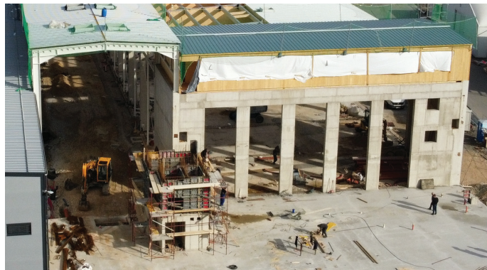
Slika 9. Gradnja armiranobetonskega dvigalnega jaška.
