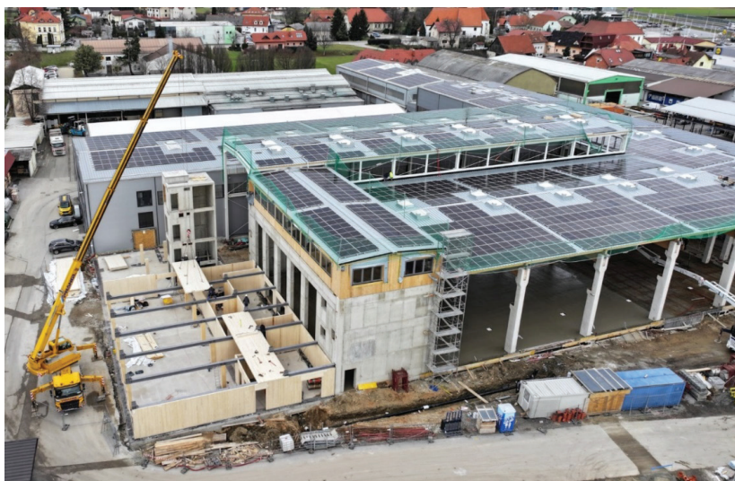
Slika 7. Gradnja lesenega poslovnega dela s CLT-sistemom.
