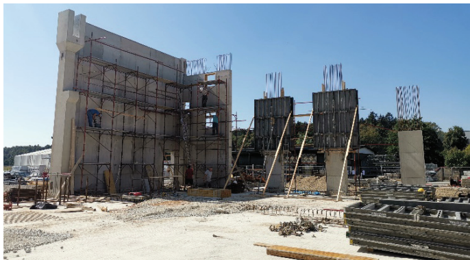
Slika 8. Gradnja armiranobetonskih slopov in sten.
