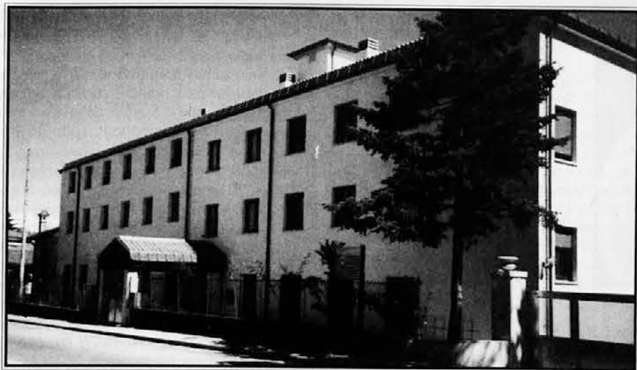
Pogled na prenovljeno stavbo Marijanišča na Opčinah
