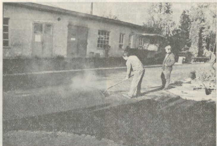
Asfaltiranje transportnih poti
