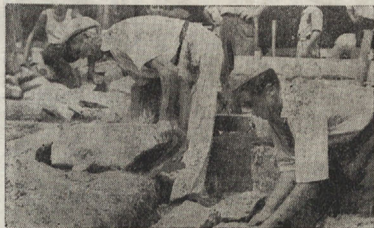
TEMELJNI KAMEN POLAGAJO
