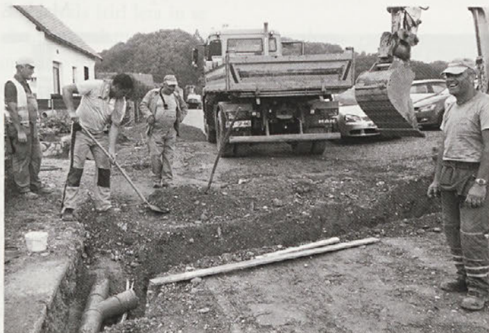
Izgradnja kanalizacije v naselju Tržec. Foto: Tadej Podvršek
