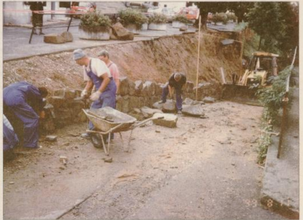
Novi podporni zid pod cerkvijo na Ptujski Gori je med pomembnejšimi investicijami, saj je veljal več kot 10 milijonov tolarjev
