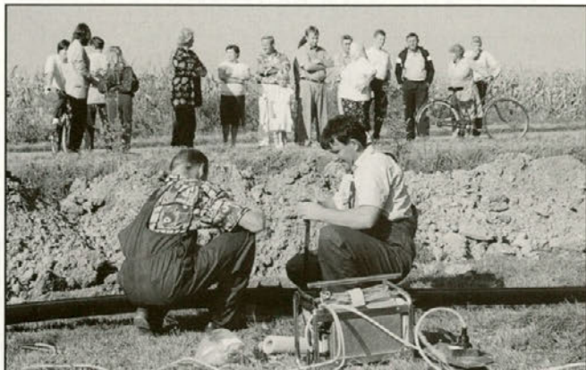
Utrinek s svečanosti ob pričetku gradnje vodovoda v Podložah.
