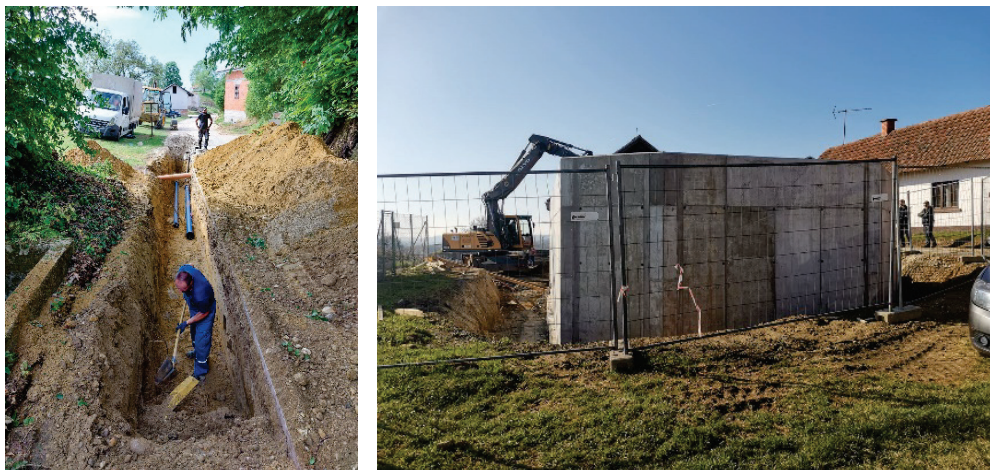
Gradnja vodovoda na Kostanju, foto: KTV Ormož.
