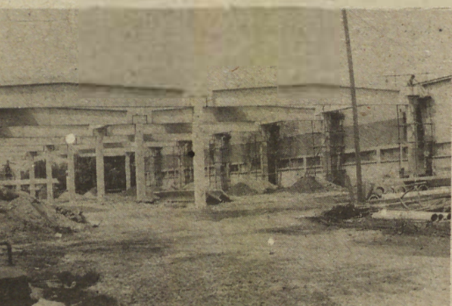
Tudi pri obratu MTT se gradi. Obrisi bodočega novega delovnega prostora in skladišča so že vidni. Tudi ta investicija bo letos končana.
