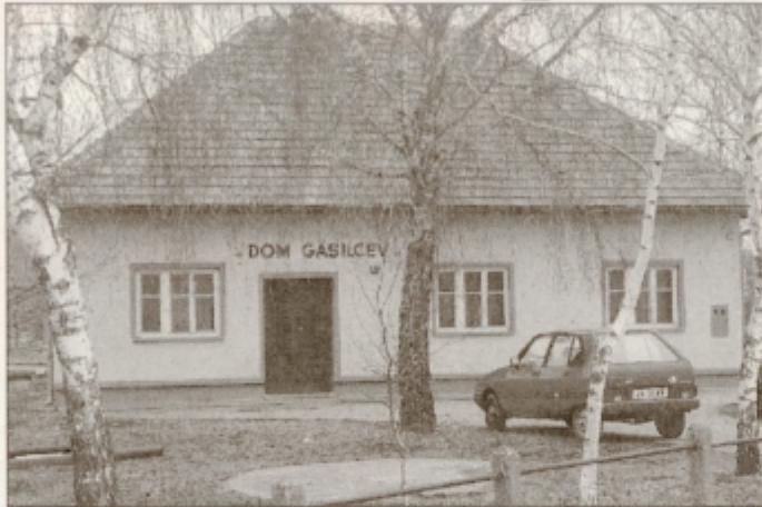
Sedanji dom bodo porušili in na istem mestu zgradili novega.
