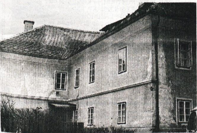
Bo razpadajoča fasada na vrtcu Antona Medveda še dolgo čakala na obnovo?
