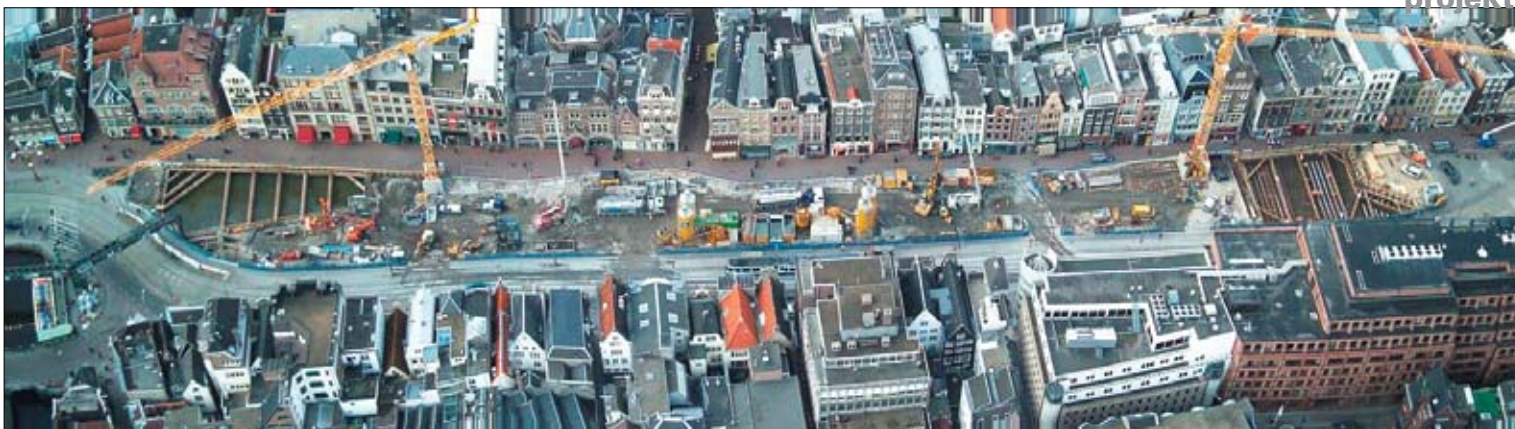
Ptičja perspektiva gradbišča
