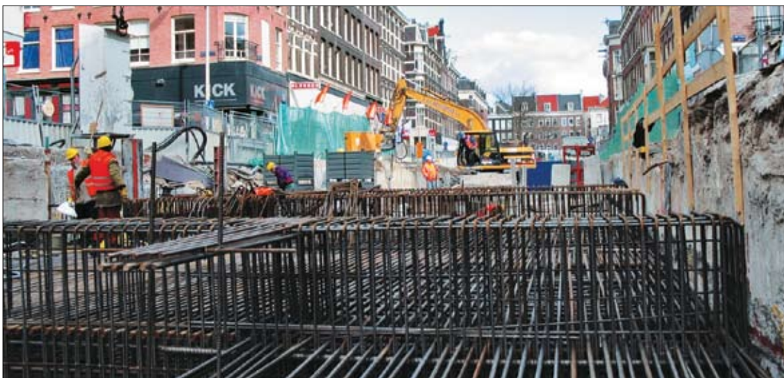
Gradbišče postaje podzemne železnice Rokin
