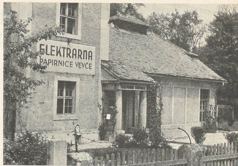
Fužine — elektrarna desni breg. Elektrarna obratuje že od leta 1922 neprekinjeno (Foto: C. Zupančič)
