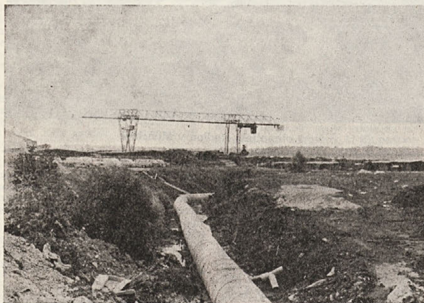
Jarek, ki je dolgo časa služil za odvajanje vode v Krko, bo končno zasut. Voda bo odtekala po ceveh ki jih vidite na sliki. Tako se bo lahko povečal tudi parkirni prostor, pa tudi sam videz podjetja bo lepši
