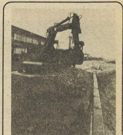
Zlasti na severnem in zahodnem delu Iskrinega industrijskega kompleksa v Stegnah že dolge mesece potekajo živahna dela. Na sliki: buldožer „v akciji“ za novo kanalizacijo ob Mikroelektroniki.
