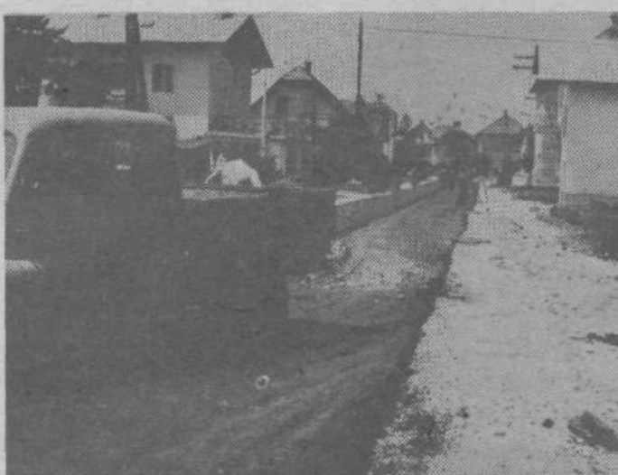
Delavci cestnega podjetja asfaltirajo Rjavo cesto v Polju
