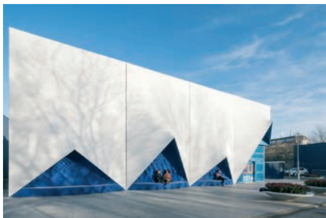
» Mobilna konferenčna zgradba v Amsterdamu: Modre elemente fasade so pri DUS Architects oblikovali in izdelali s Henklovimi topljivimi lepili.
