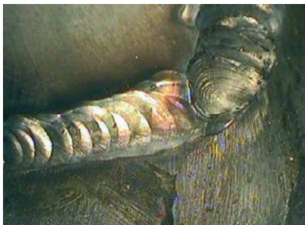
» Slika 5: Pregled na težko dostopnih mestih (videoscope, borescope)
