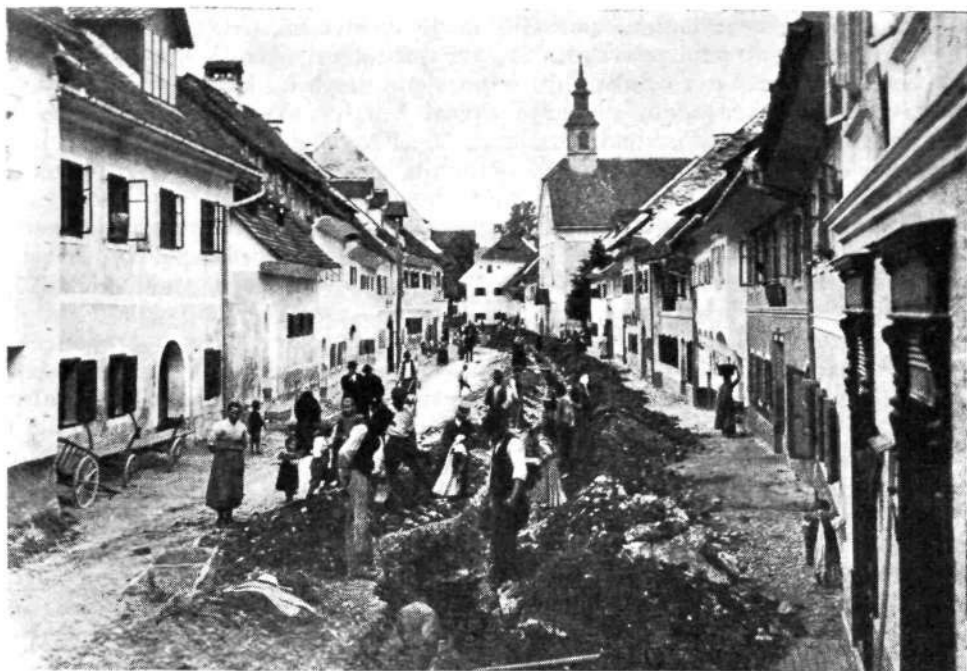
Napeljevanje vodovoda po Spodnjem trgu
